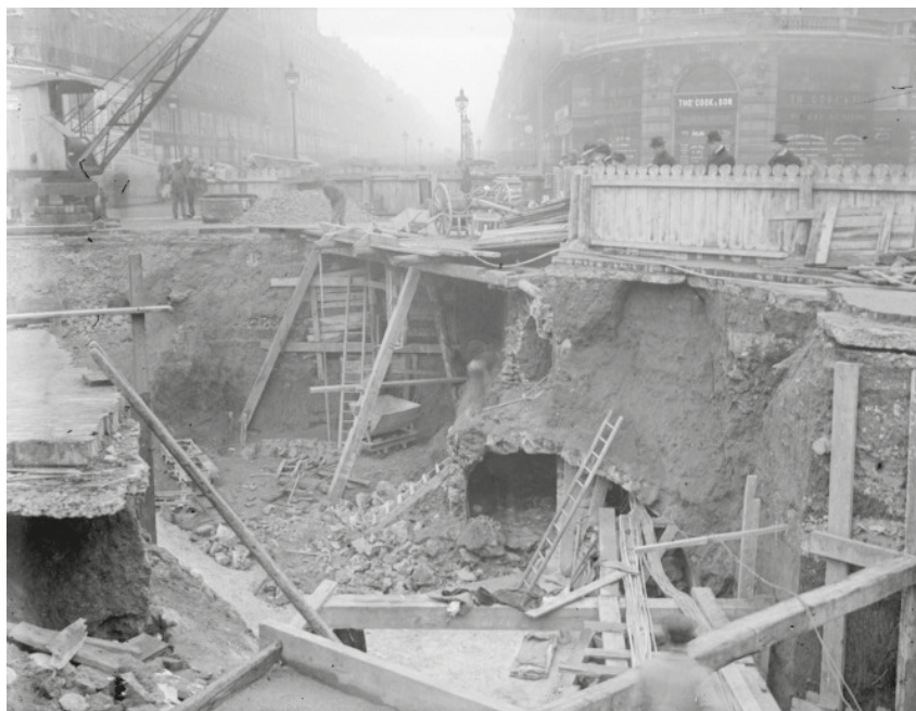
Konstruktion av Paris métro, 1900, där arbetarna insjuknade i "la gale de ciment", handeksem betingat av kromat i cementen. Bild: Wikimedia commons
