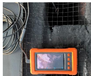
Fig. 12. Undersökning av kanal inifrån med inspektionskamera via skorstenen
